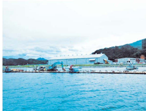
岸壁延伸中の国際埠頭
