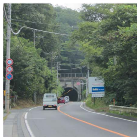
白鳥トンネル
