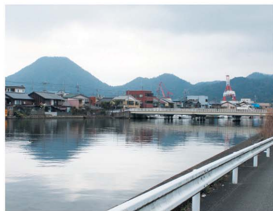
老朽化がすすむ大和橋 ※ アセットマネジメント…資産を効率よく運用すること。
