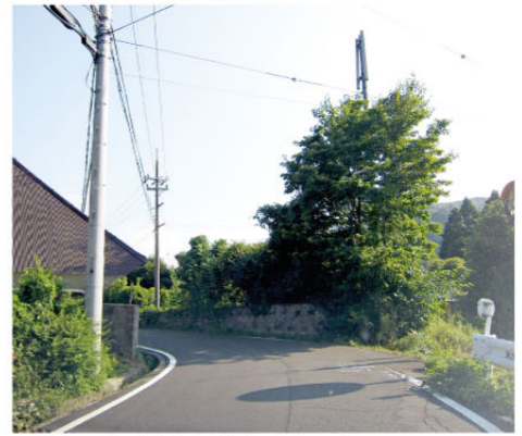
田井中田線(大山)道路改良工事
