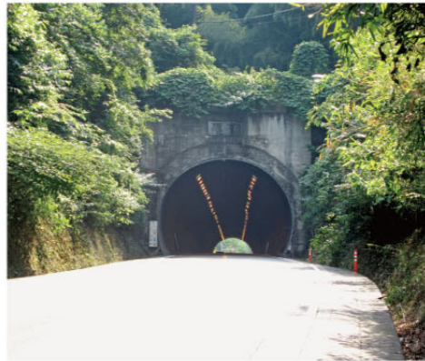
白鳥トンネル4車線化(H32年完成予定)
