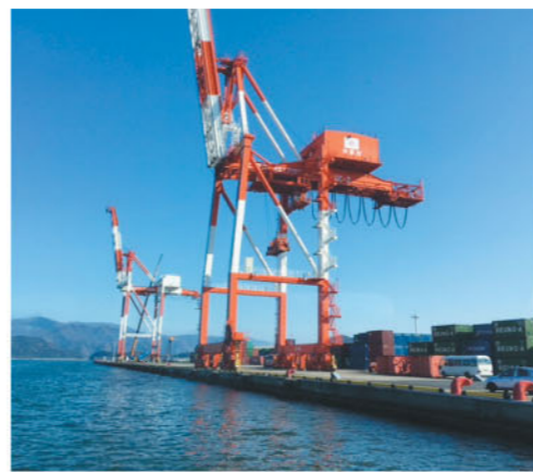
京都舞鶴港 ガントリークレーン
