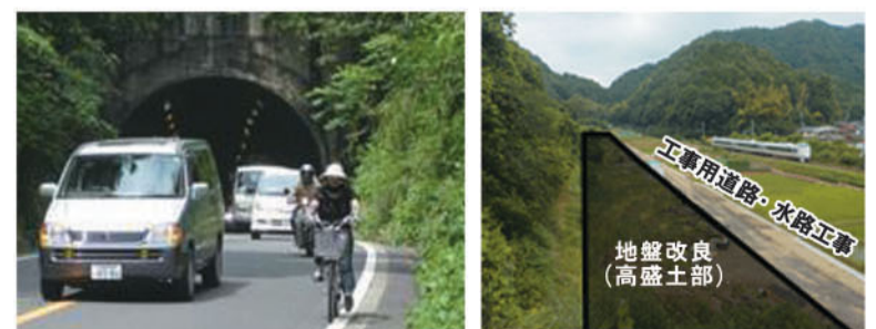
路肩狭小の白鳥トンネル
