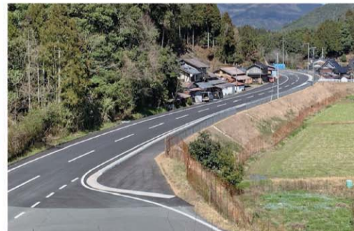
府道567号 地頭四所停車場線（西方寺）
