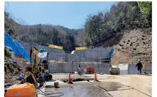
砂防堰堤工事（上福井：大島川）
