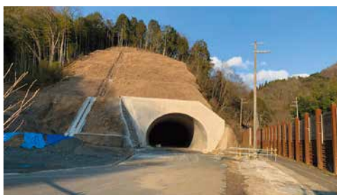
新白鳥トンネル
