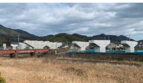
国道27号西舞鶴道路
